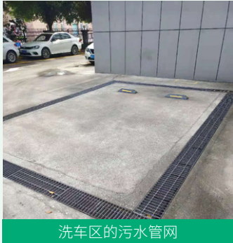
洗车区的污水管网
